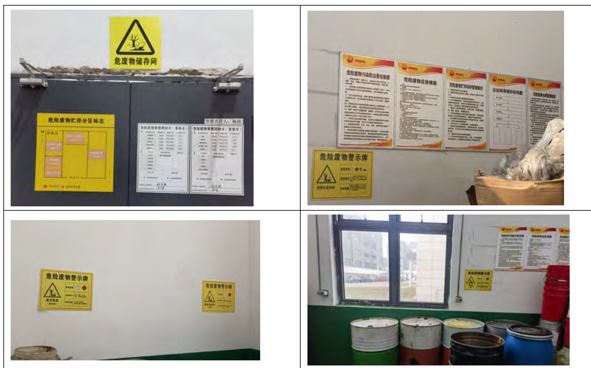
图 10 企业危废暂存仓库
