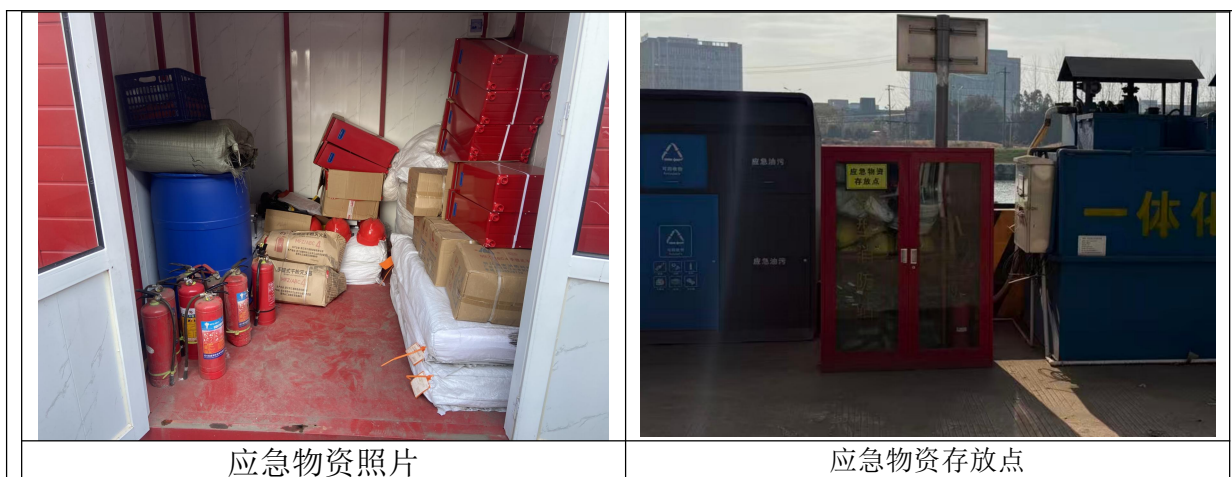
图 4-7 环保设施及风险防范设施照片
