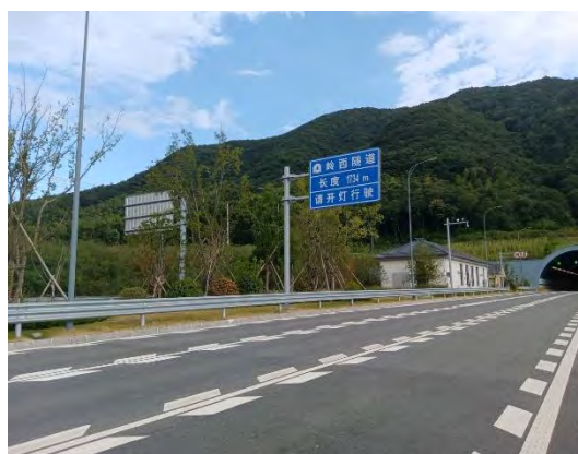
岭西隧道进口施工场地恢复
