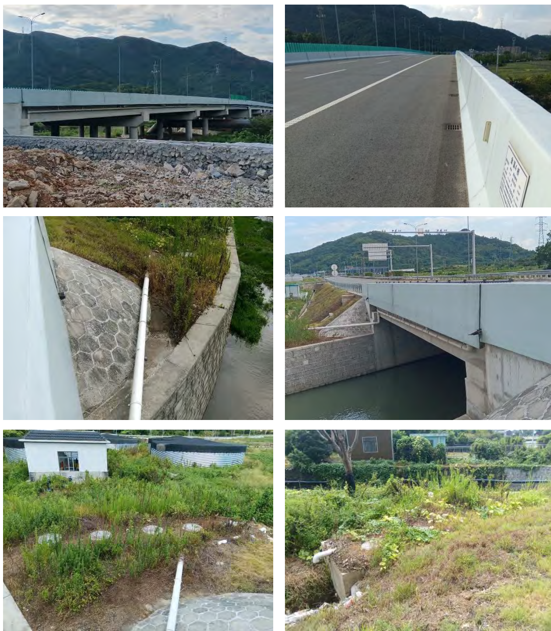
图 9.2-2 桥面雨水径流收集系统及收集池
