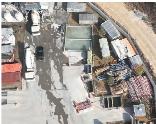
集中施工场地地面硬化
