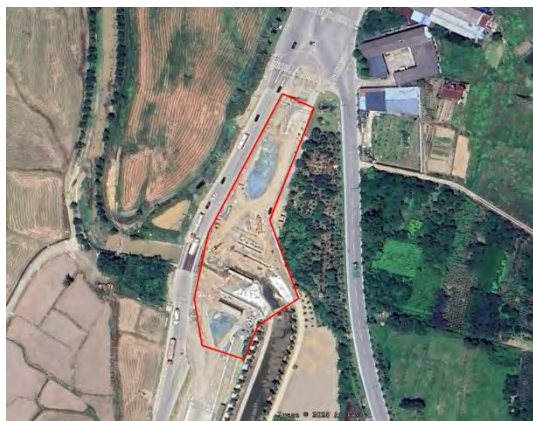
K10+200 施工场地红线内占地
