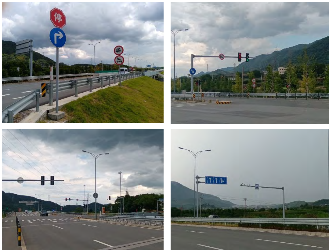
图 11.1-2 公路沿线警示标识及监控设施
