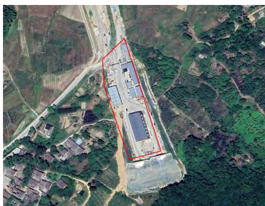
岭西隧道进口施工场地红线内占地
