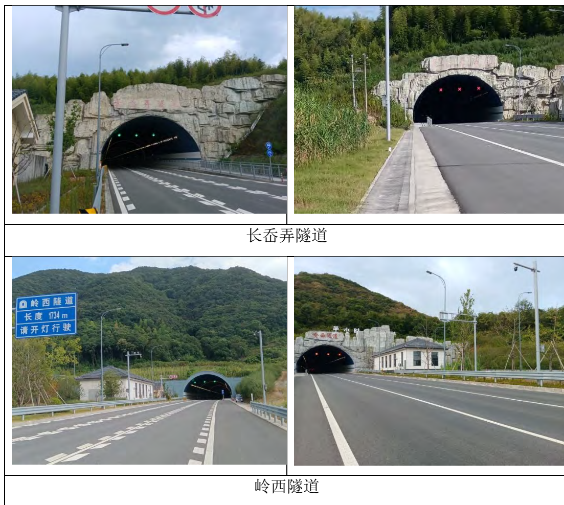
图 3.3-6 工程实际建设隧道工程
