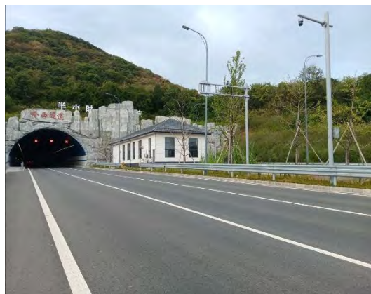
岭西隧道出口施工场地恢复
