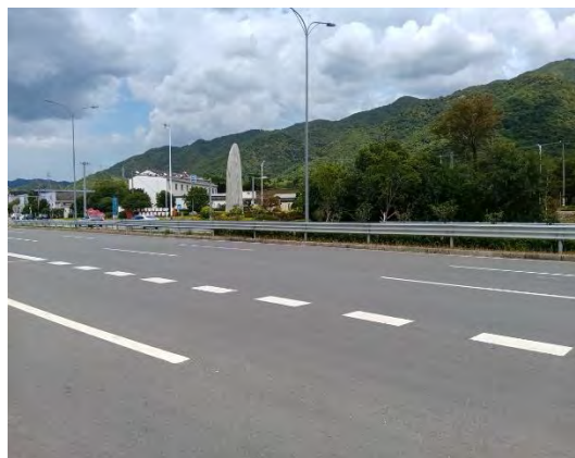
K10+200 施工场地恢复
