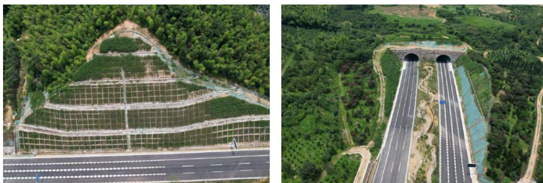
边坡及隧道口护坡
