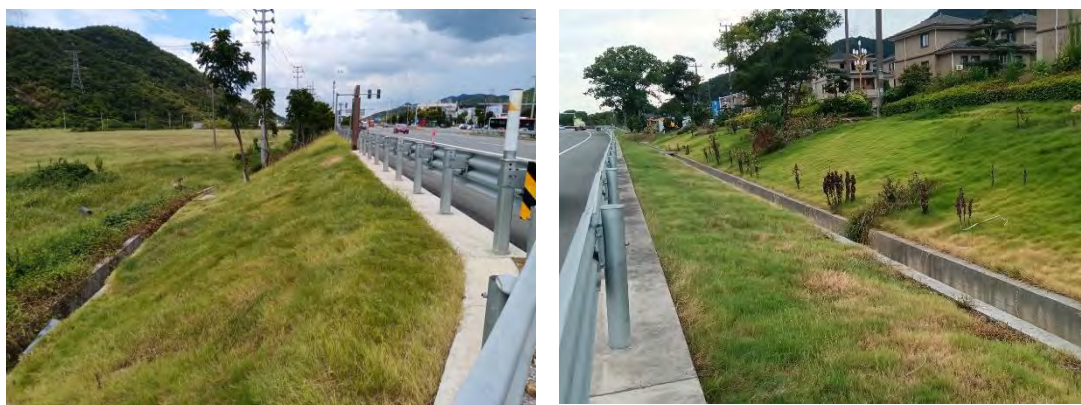
图 8.2-1 工程绿化及护坡照片
