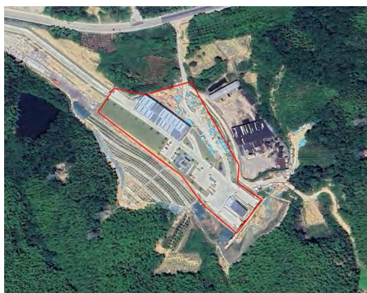
长岙弄隧道进口施工场地红线内占地
