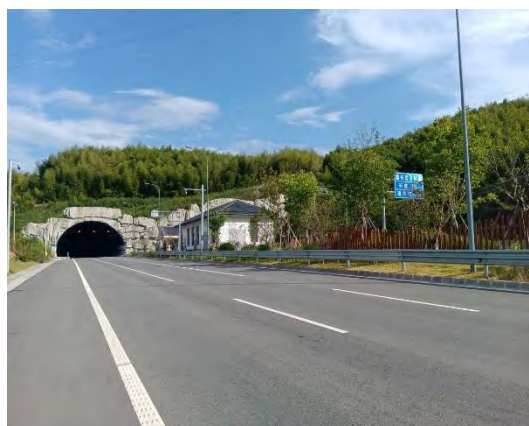
长岙弄隧道进口施工场地恢复
