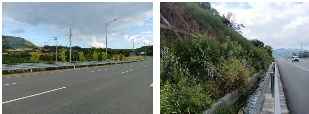
图 6.6-1 工程绿化及护坡照片
