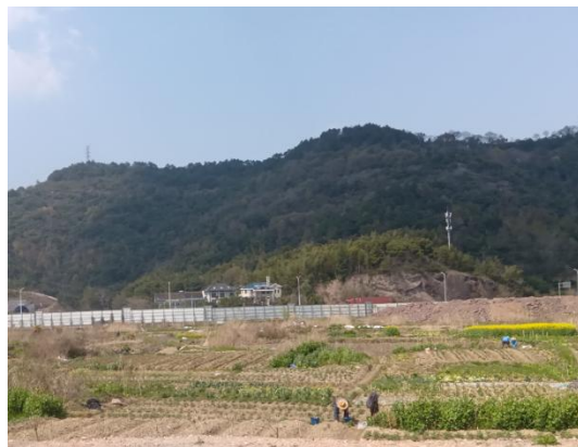
剡江 1#施工场地恢复情况
