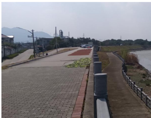
剡江 2#施工场地恢复情况（工程占地范围内）
