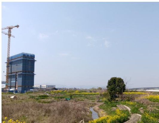
东江 5#施工场地恢复情况
