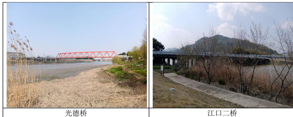
图 3.3-10 剡江桥梁实景图
