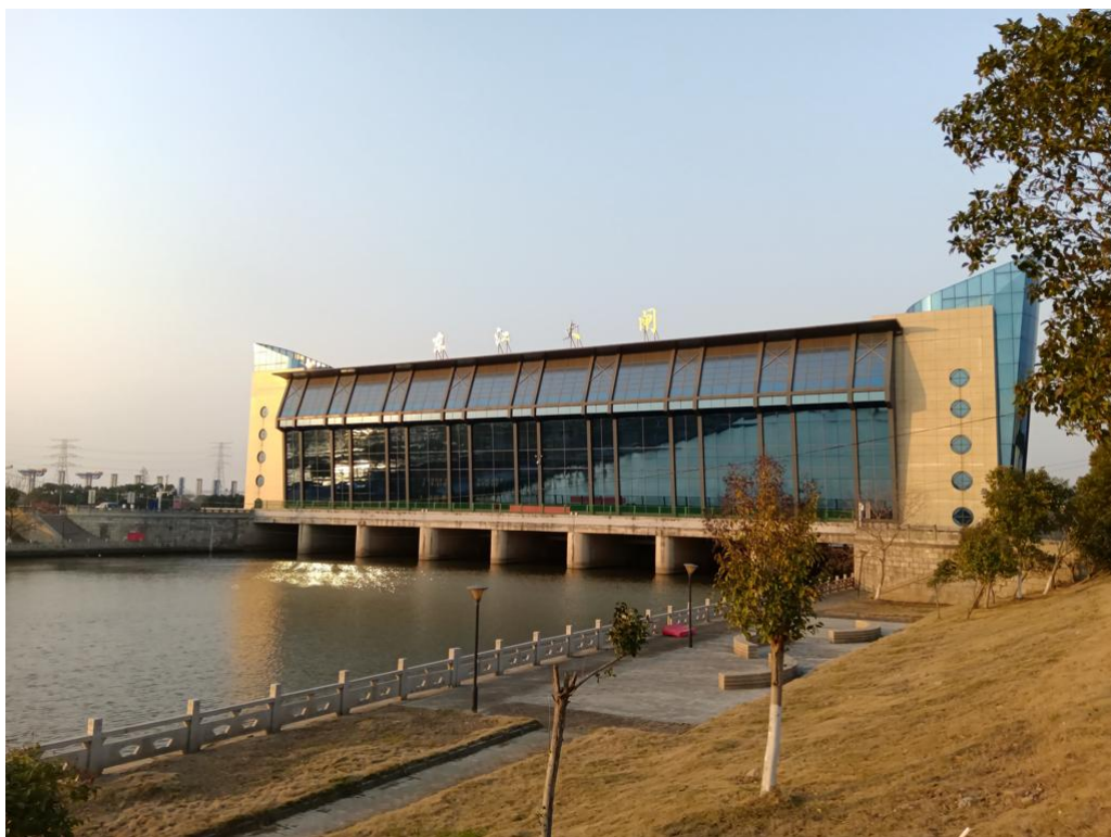
图 3.3-8 东江大闸实景图
