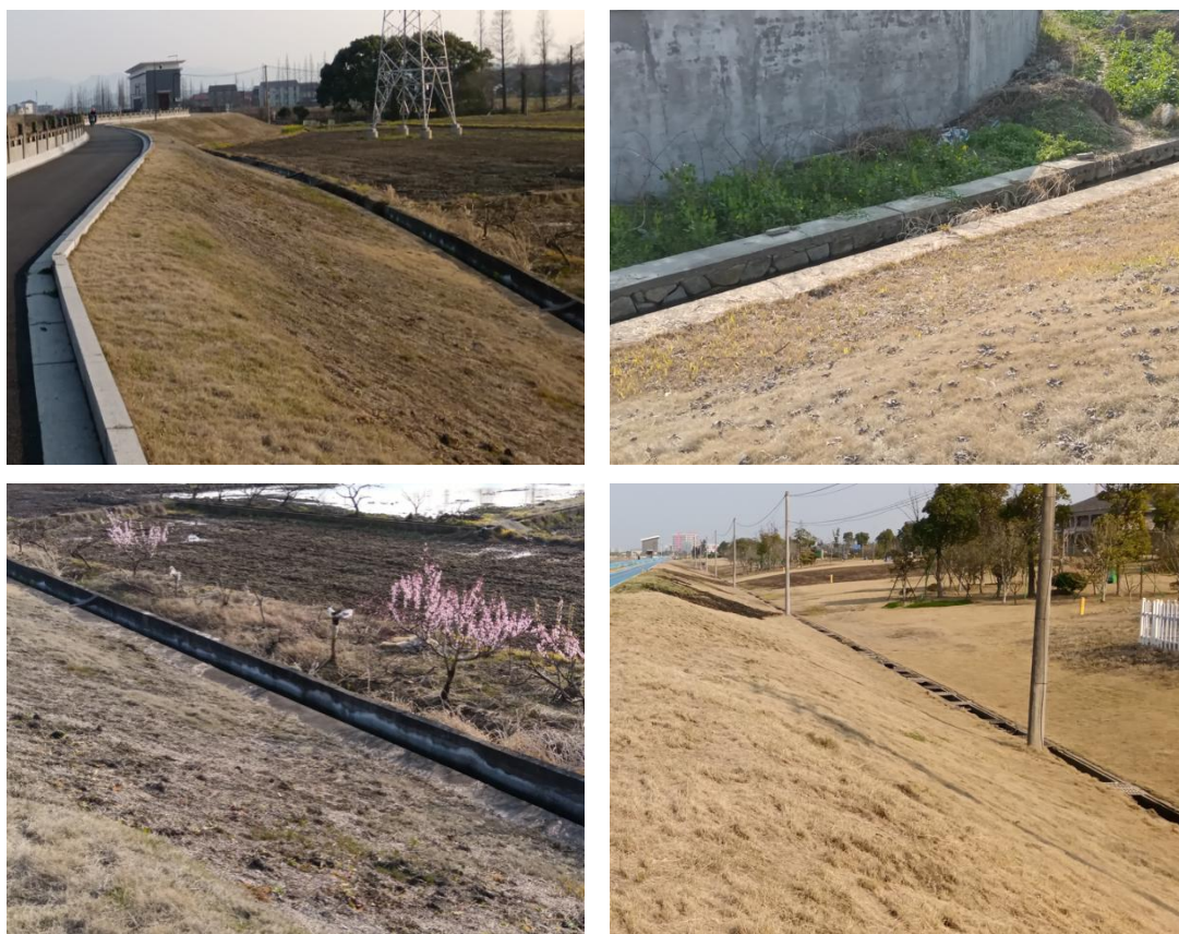
图 7.2-1 堤防背水面集水沟照片
